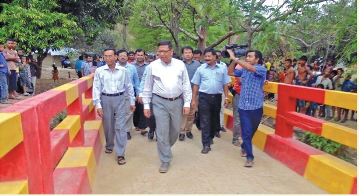
(দেবতা পুকুর) এর ব্রীজ নির্মাণ কাজের অগ্রগতি পরিদর্শন করছেন বোর্ডের মাননীয় চেয়ারম্যান জনাব নব বিক্রম কিশোর ত্রিপুরা, এনডিসি
